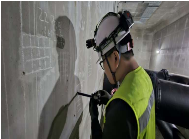
탄산화 깊이 측정
