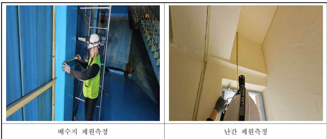
【사진 3.1】 시설물 외관조사
